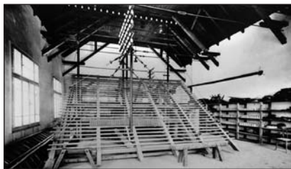
„Tető a laborban” ('12-ben még alapvetően légvezetékek voltak)
