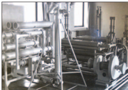
8. ábra. A diplexer és az oldalsáv szűrő koaxiális elemekből volt kialakítva. A ventilátor az abszorber ellenállást hűtötte, amelyen eldisszipált a nemkívánatos alsó oldalsáv energiája
