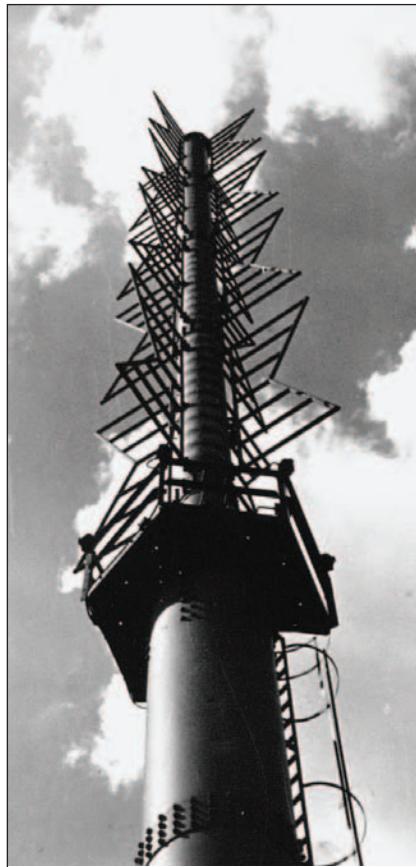
7. ábra. Az RFT adó 4-emeletes Super-Turnstyle („lepke”) antennája viharos időben. A kereszt dipóllok illetően való kialakítása a relatív nagy sáv szélesség érdekében történt
