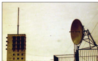
19. ábra. A BHG beadó-mikró vevőoldali antennája a Hargita-Szálló tetején
